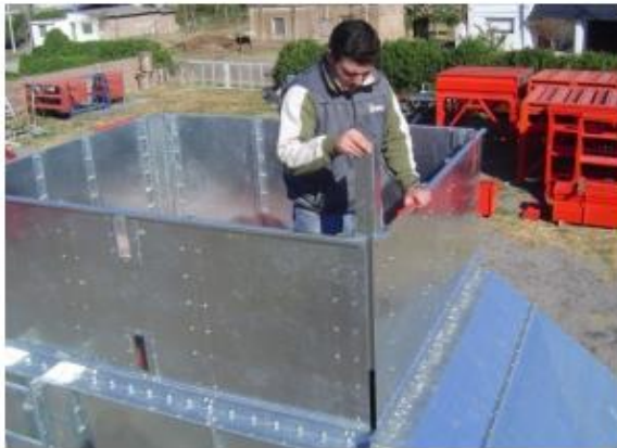
Armado de la Tolva
