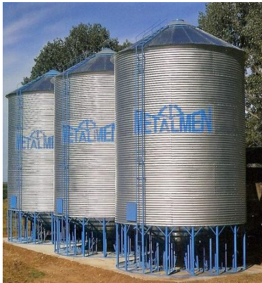
Sencilla obra civil
